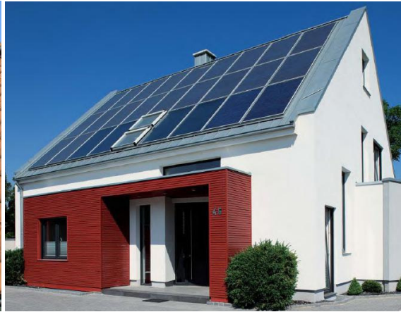
Solarthermische Anlage mit Flachkollektoren
