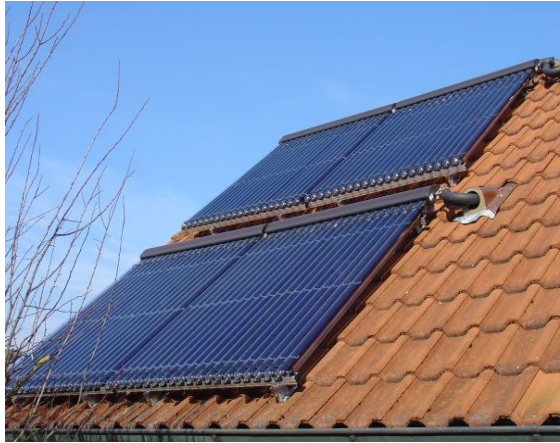
Solarthermische Anlage mit Röhrenkollektoren
